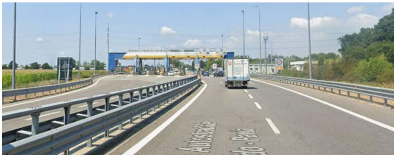
Autostrada A7 – casello Bereguardo-Pavia Nord – bretella di raccordo a due corsie per senso di marcia
