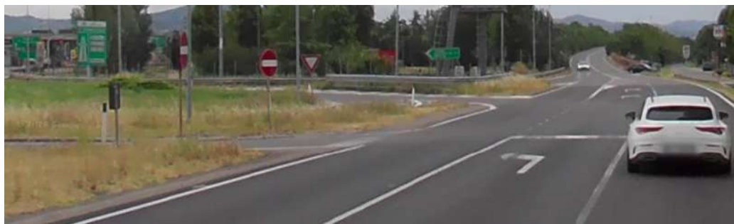
Autostrada A21 – casello Casteggio-Casatisma - svincolo canalizzato all'uscita del casello con la SS35
