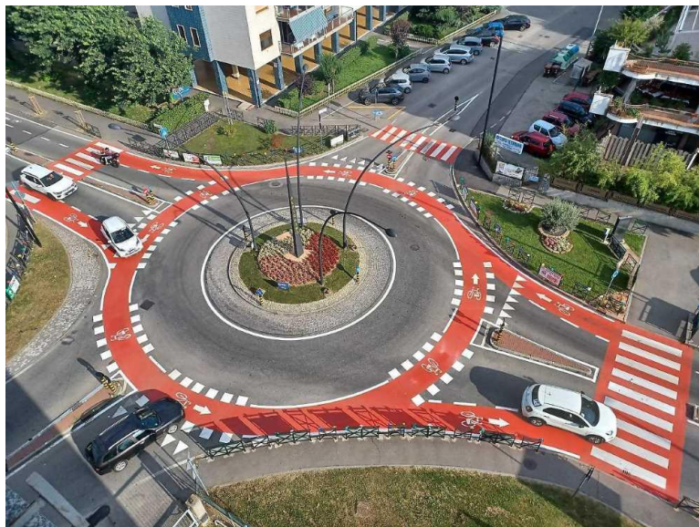
Esempio di anello ciclabile realizzata nella C.M. di Torino, da evidenziare che in questo caso la scarsa delimitazione tra porzione destinata ai ciclisti e al traffico veicolare comporta possibili invasioni da parte delle auto.
